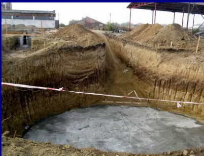
Etape din execuția fundației și a platformei adăpostului de vaci
