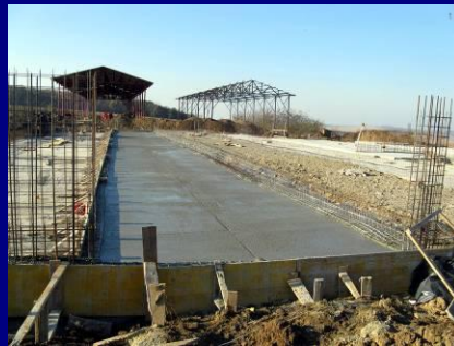
Etape din execuția fundației și a platformei adăpostului de vaci
