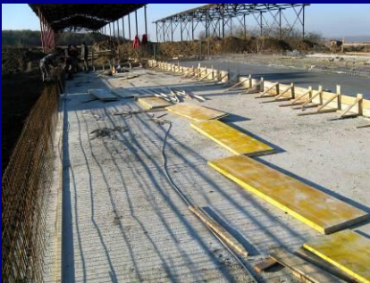
Etape din execuția fundației și a platformei adăpostului de vaci
